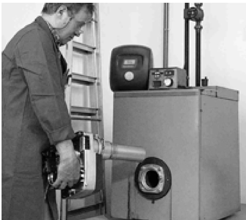
Abb. 10: Brenner-Kessel-Montage I
