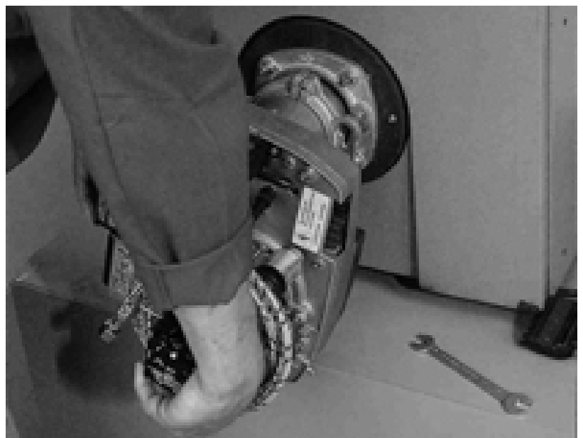
Abb. 12: Brenner-Kessel-Montage III
